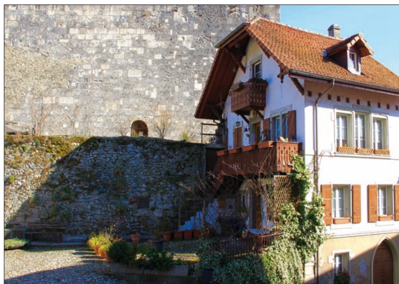
Dans la rue qui porte son nom, la muraille qui reste du Château médiéval et une jolie demeure.
